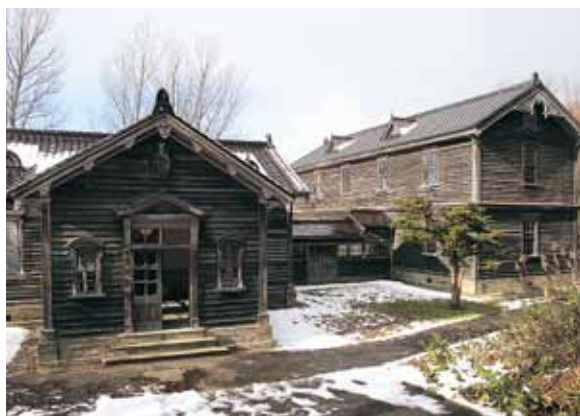
木造瓦屋根、下見板張りなどはいかに和風だが 屋根のドーマー(出窓)や上げ下げ窓は明治の流行のようだ
