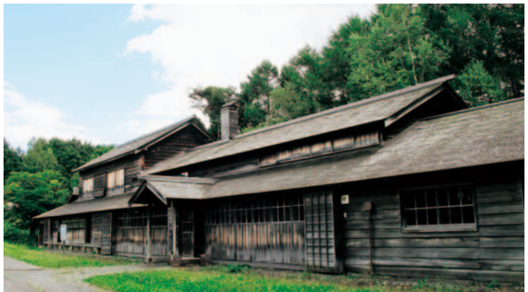
旧田村家北誠館蚕種製造所の外観 一部2階建ての切妻・榎ぶき屋根 明治38年(1905)の建築
