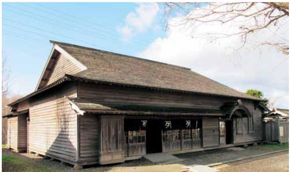
入母屋桁屋根のシンプルで大きな構え 正面の半分以上が店舗の間口 右側に住居部分の玄関がある
