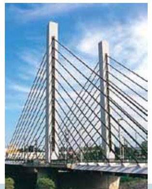
斜張橋のミュンヘン大橋
