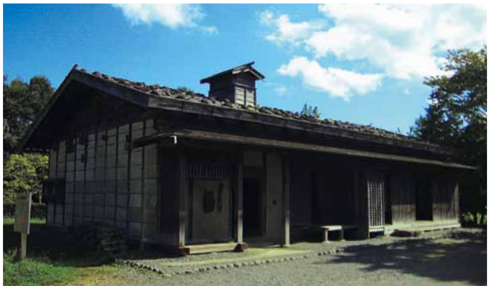
農家住宅とはいえどっしりとした構え 屋根の突出部はいろいろの煙出し 枳葺きに置き石というのも珍しい
