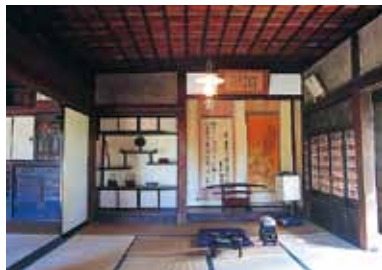
炬を切った茶の間上部のヤチダモの小屋組みに重厚感がある 他にも欄間や障子に北海道には見られない細工が
