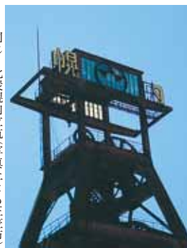
同じく北炭幌内立坑(写真上とも三笠市)
