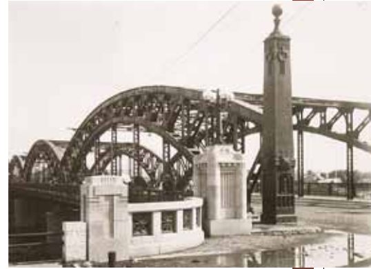
橋のたもとからしてこの重厚な造り 欄干などの浮き彫り、シャンデリアの装飾は 現代でも十分に通用する意匠(昭和5年撮影)
