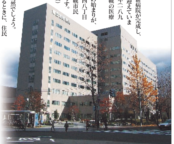
JR桑園駅北側にそびえる市立札幌病院
