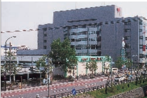
向こうにそびえるのは中央郵便局、手前はボウリング場と昔の面影はない
